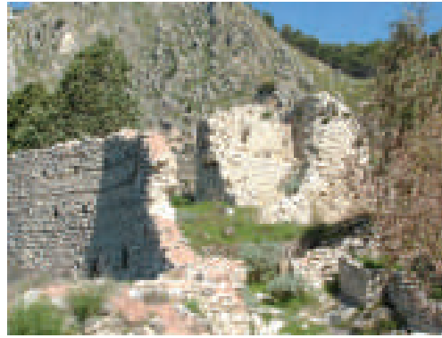
10. Torre di avvistamento
