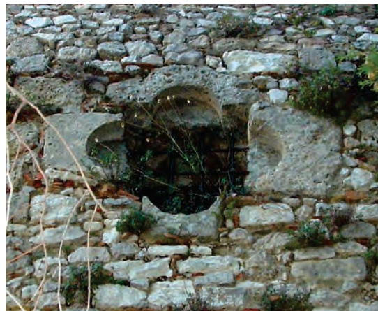
Santa Maria dell'Udienza, particolare della finestra quadrilobata.
