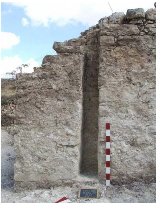
Fig. 33 - Particolare della guida per la chiusura a saracinesca (Torre B).
