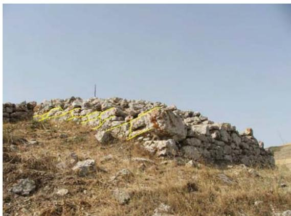
Fig. 117 - Particolare della tecnica muraria di Tipo 1, detta anche "a gradoni" (Torre A).
