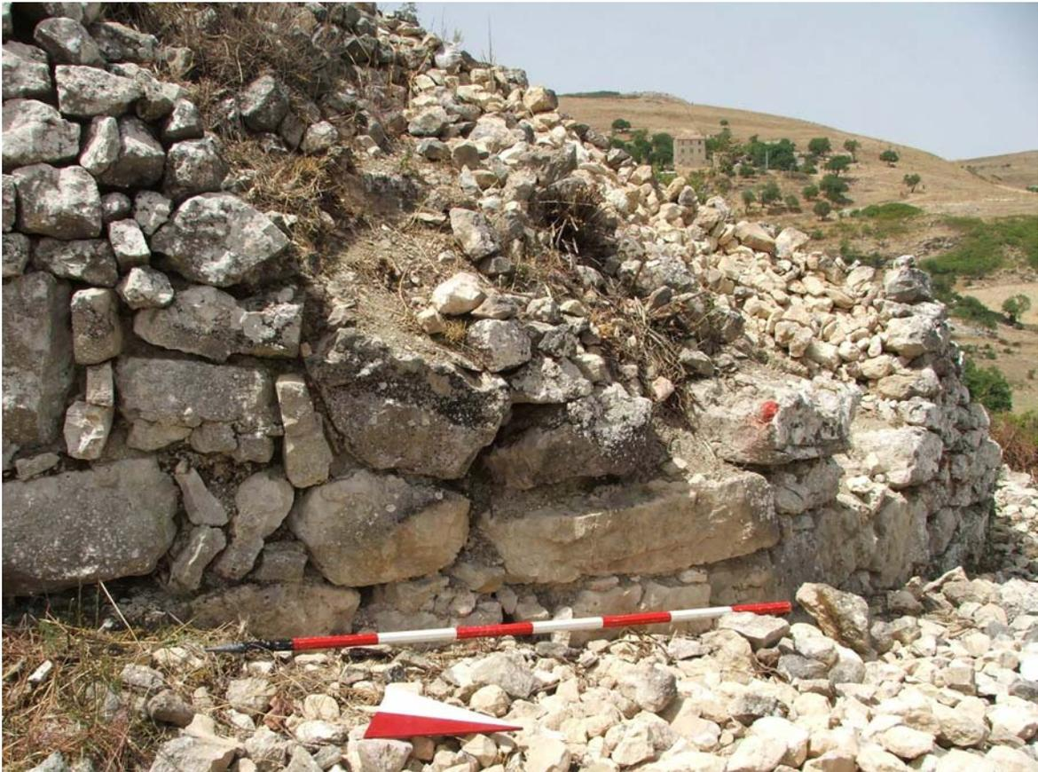
Fig. 51 - Particolare dell'emplekton della Torre D. Le pietre di minore dimensione sono dovute a moderni spietramenti agricoli.
