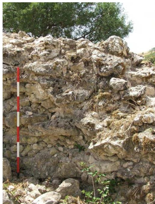
Fig. 59 - Particolare dell'emplekton della Torre E.
