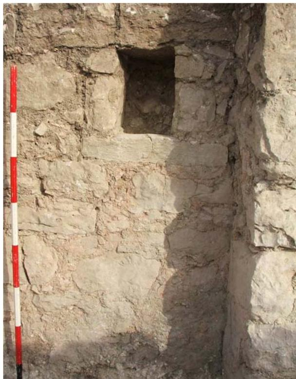
Fig. 36 - Particolare dello stipite del portone interno e dell'incasso della chiusura orizzontale (Torre C).
