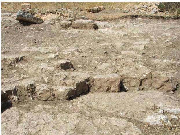
Fig. 136 - Particolare del perimetro S/E della chiesa. Si noti come le murature poggino direttamente sul banco roccioso.
