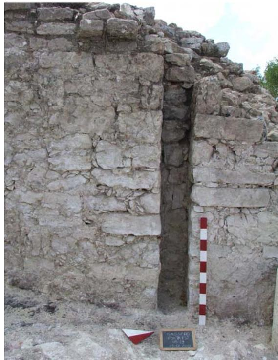
Fig. 34 - Particolare della guida per la chiusura a saracinesca (Torre C).
